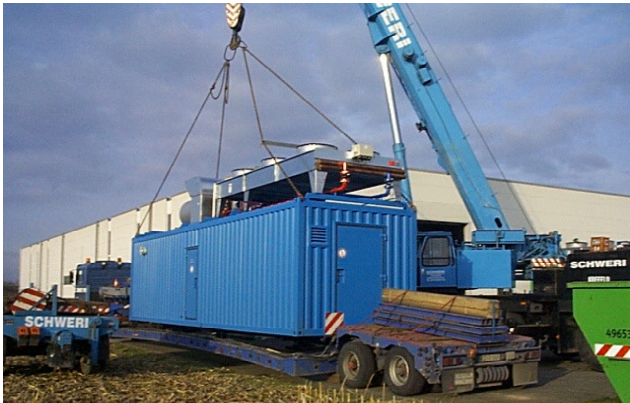
Abb. 11: Verladung eines BHKW-Containeraggregats
